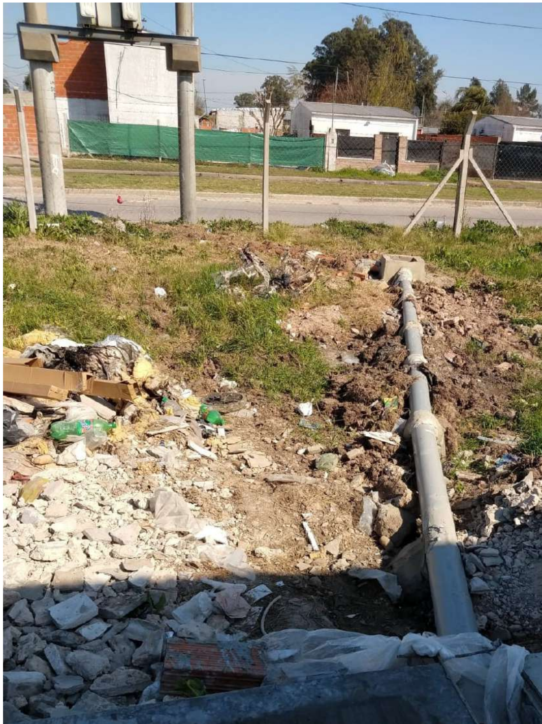
Espacio a rellenar y colocar malla a colector.
